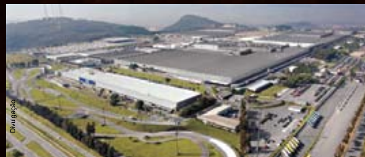
Fábrica da Fiat, em Betim, Minas Gerais
